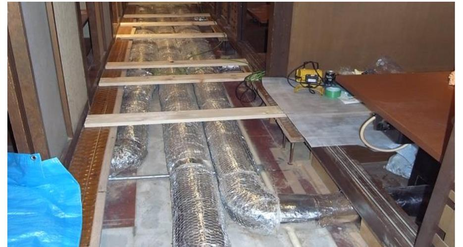
正しい排気ダクトの施工事例
